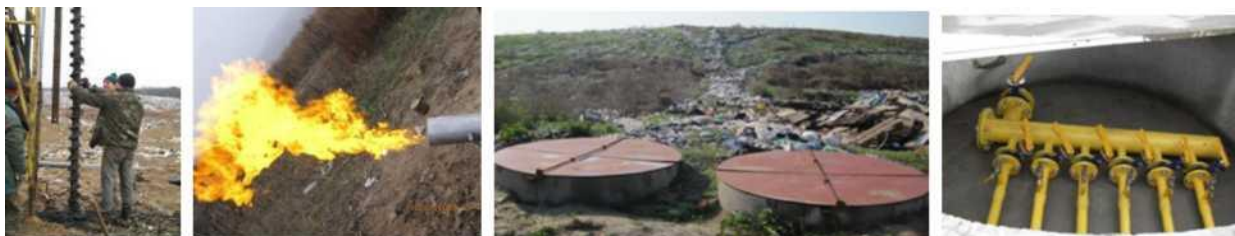
Рис. 7.2.1 – Елементи системи збору звалищного біогазу
