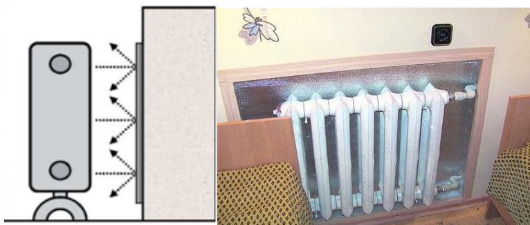
Рисунок 2.7 — Влаштування віддзеркалювального екрану на радіаторній ділянці стіни
