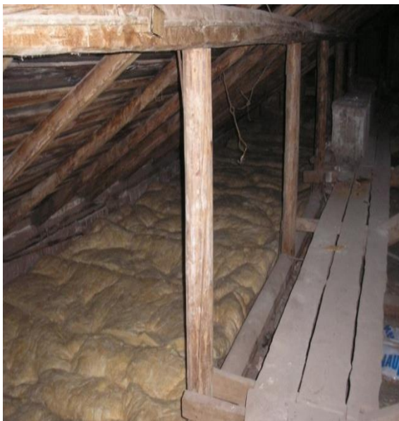
Рисунок 2.14 — Утеплення горища мінераловатними плитами
