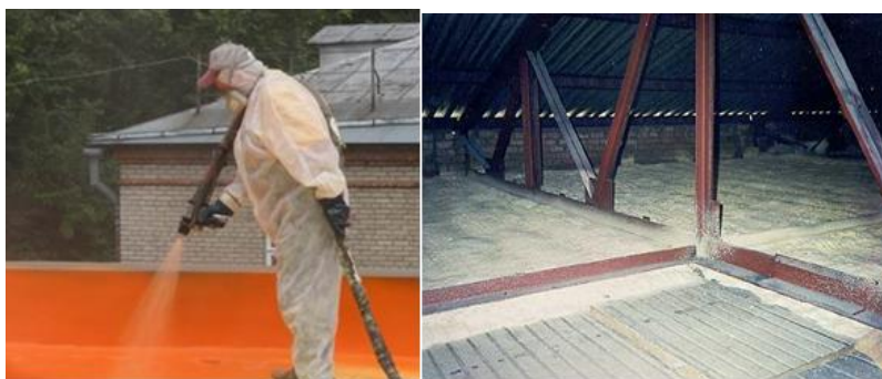
Рисунок 2.12 — Використання методу утеплення напленням пінополіуретаном:
