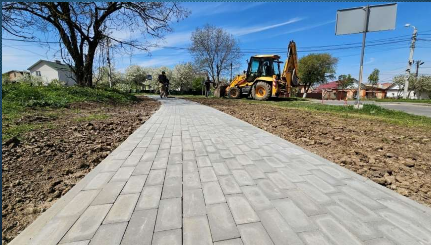
Поточний ремонт тротуару на вул. Ранковій
