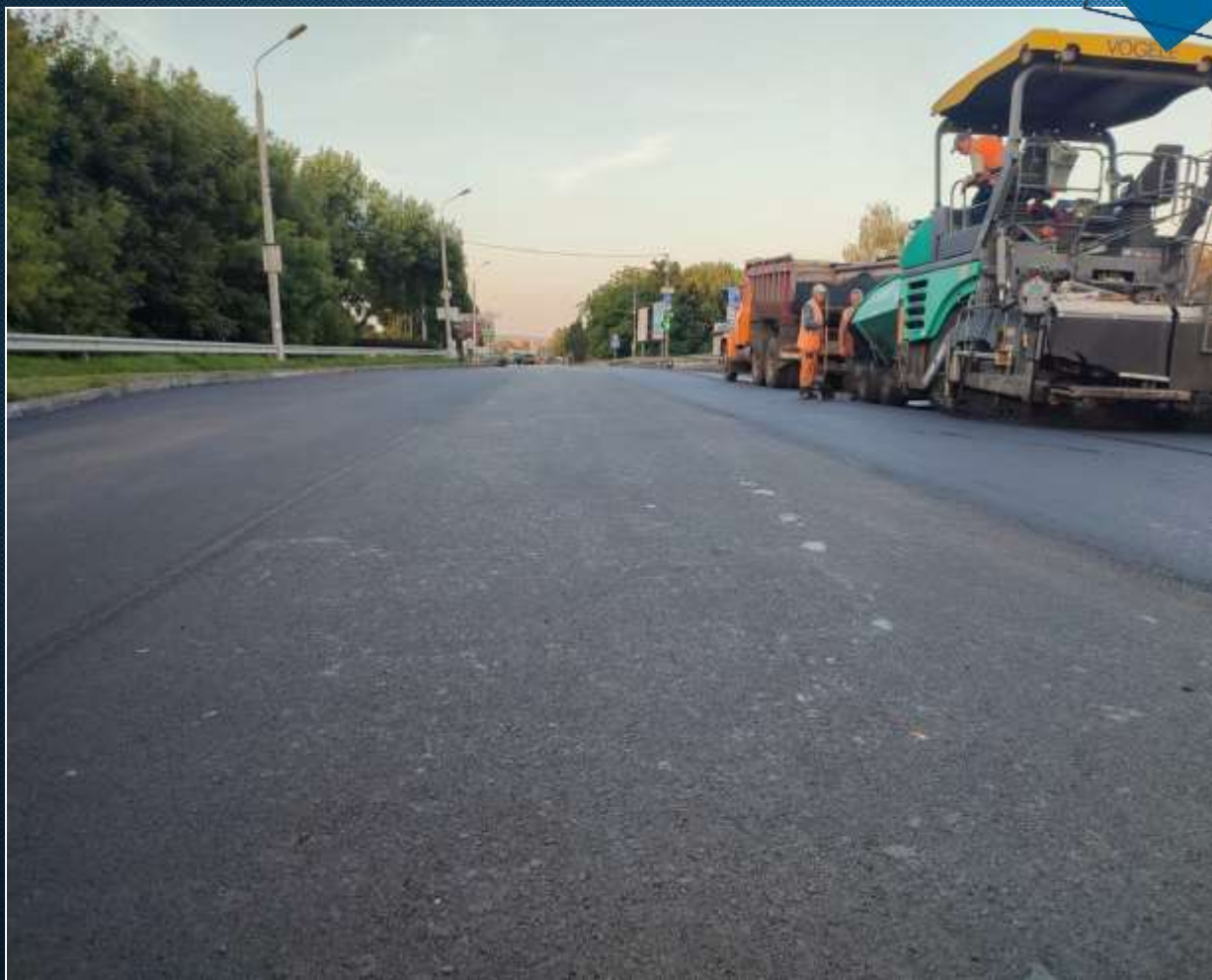
Поточний ремонт на перетині вулиць Хороброго – Грушевського
