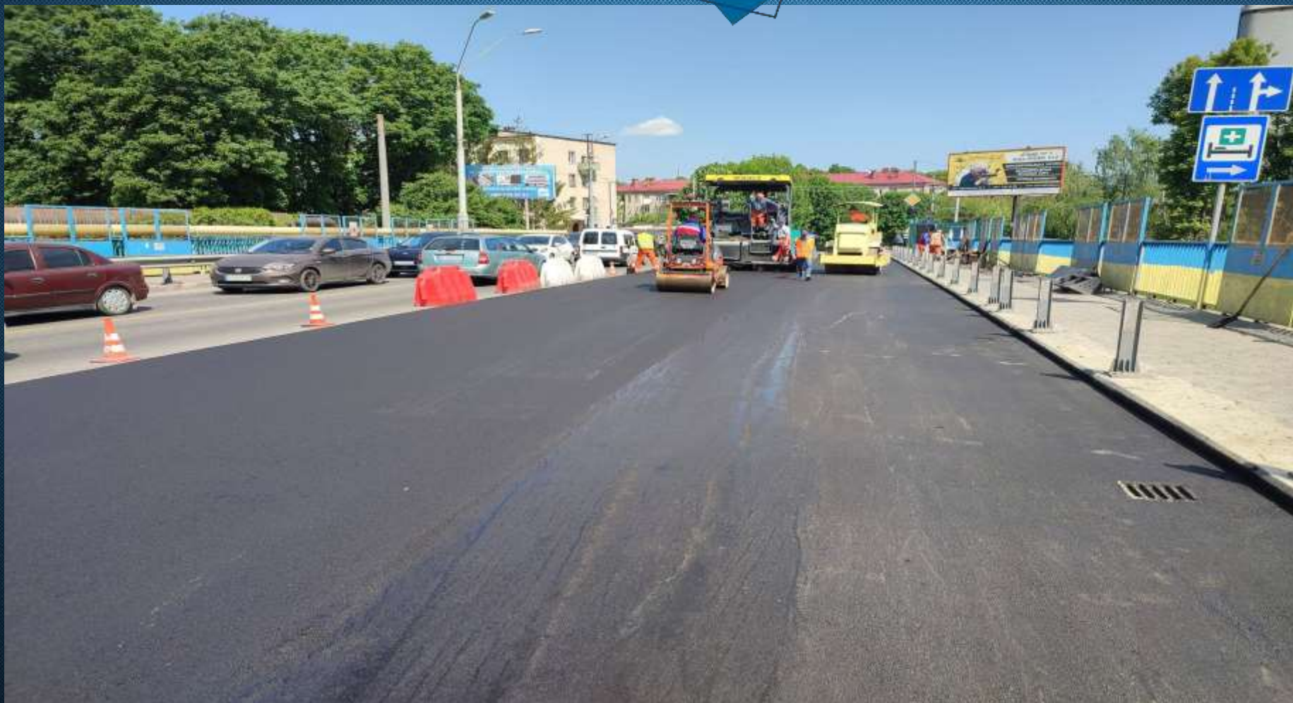
Поточний ремонт шляхопроводу на вул. Грушевського
