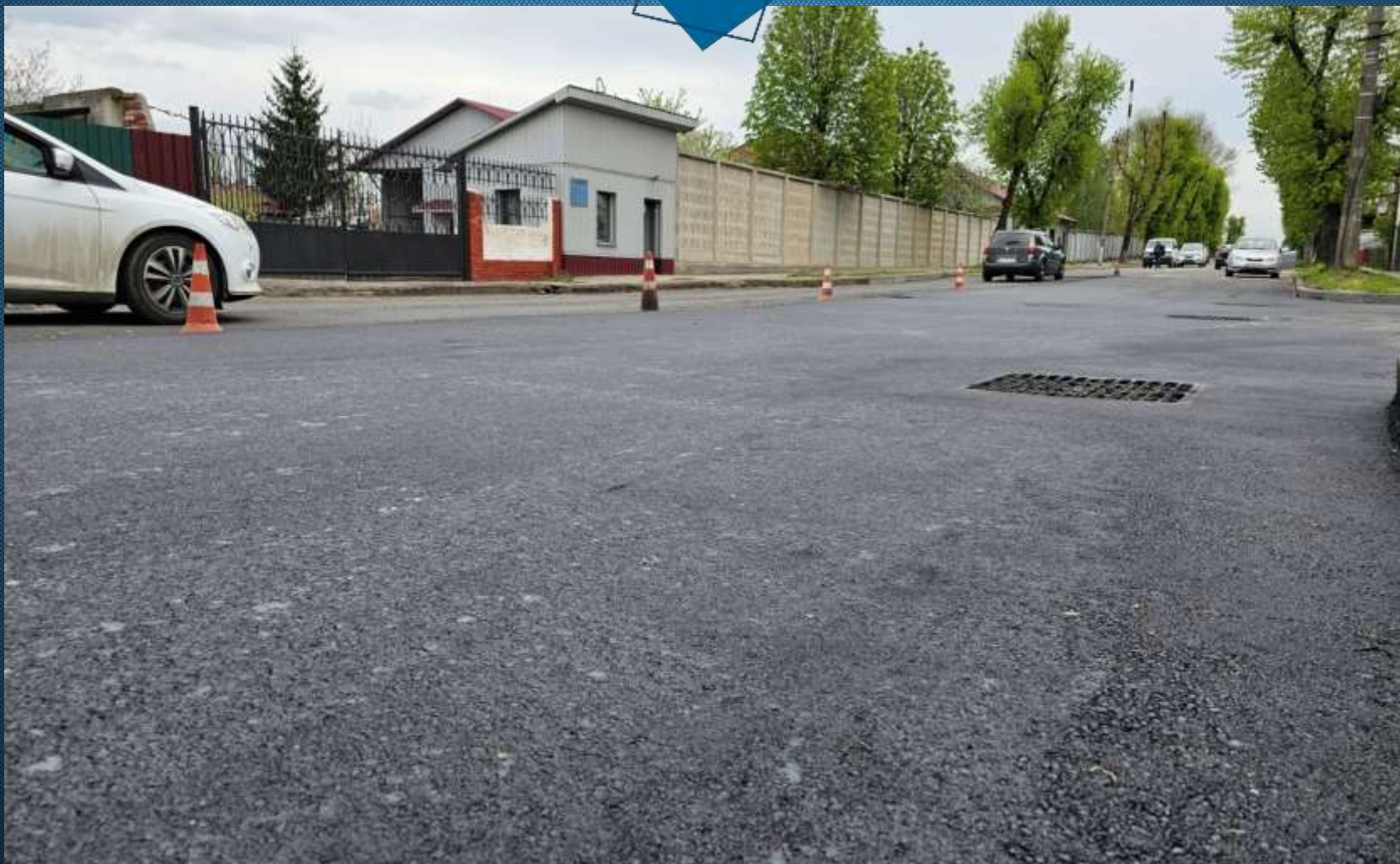
Поточний ремонт вул. Чорновола
