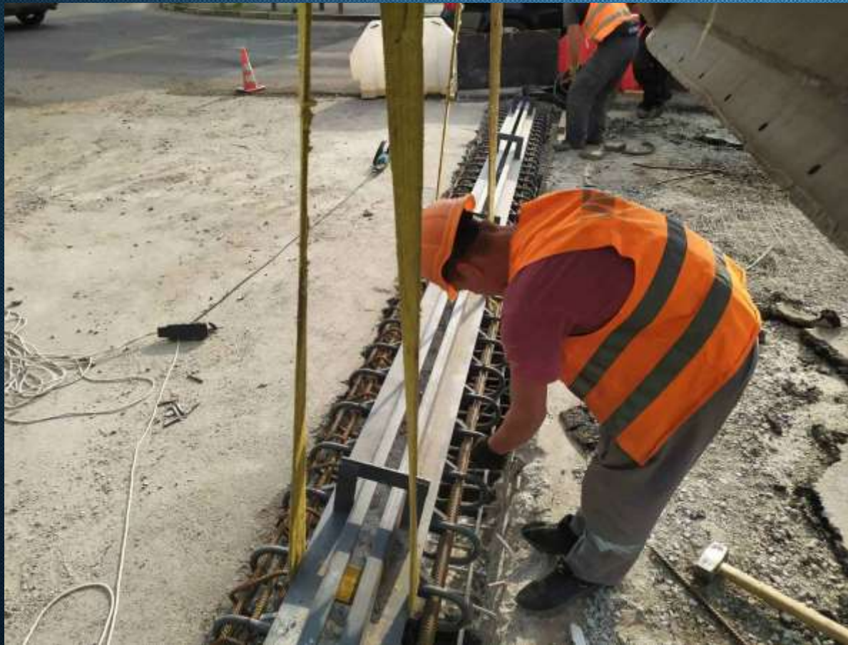
Заміна деформаційних швів на шляхопроводі на вул. Грушевського
