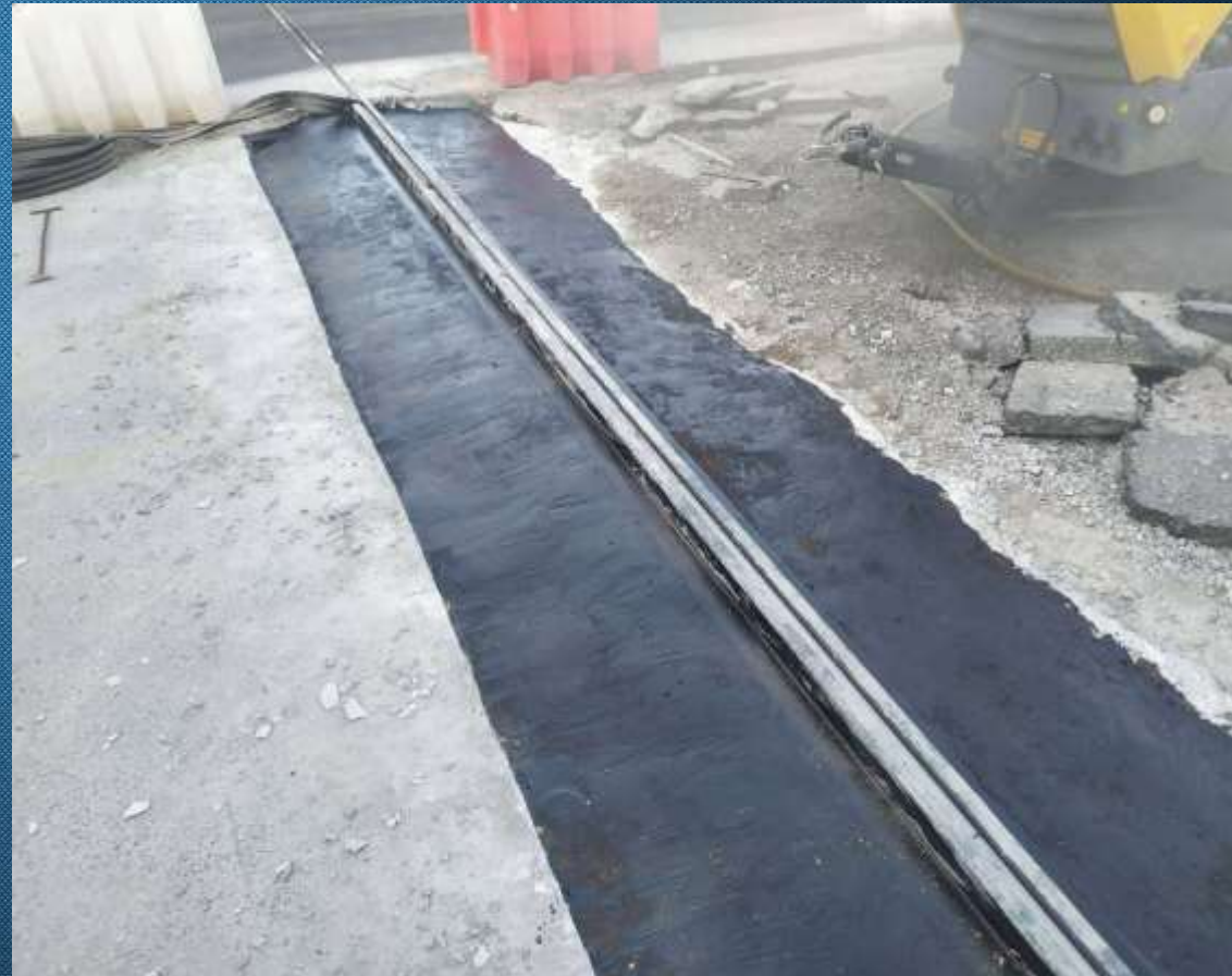
Заміна деформаційних швів на шляхопроводі на вул. Грушевського
