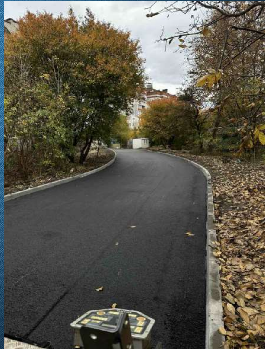
Капітальний ремонт вул. Ранкової
