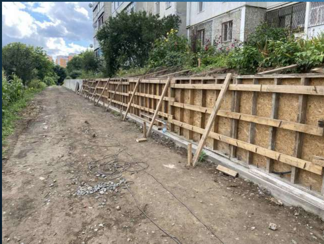
Капітальний ремонт підпірної стінки на вул. Гайова, 8
