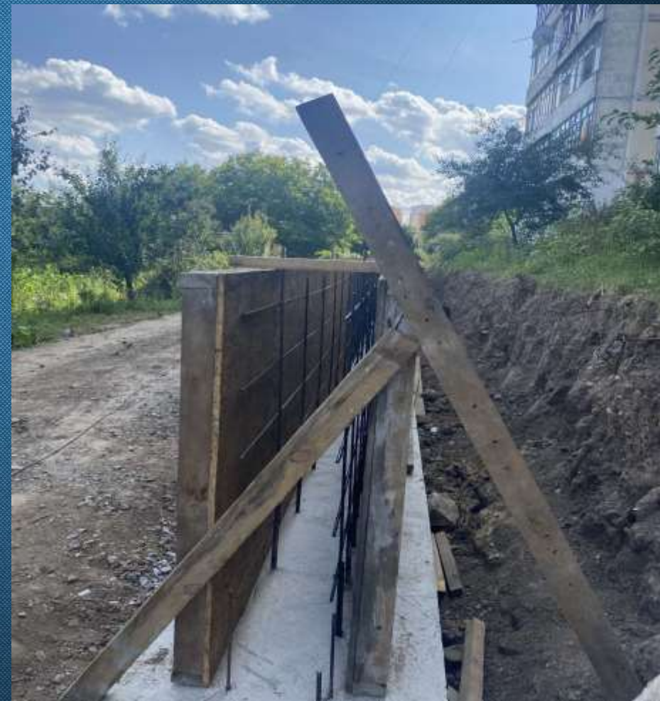
Капітальний ремонт підпірної стінки на вул. Гайова, 8
