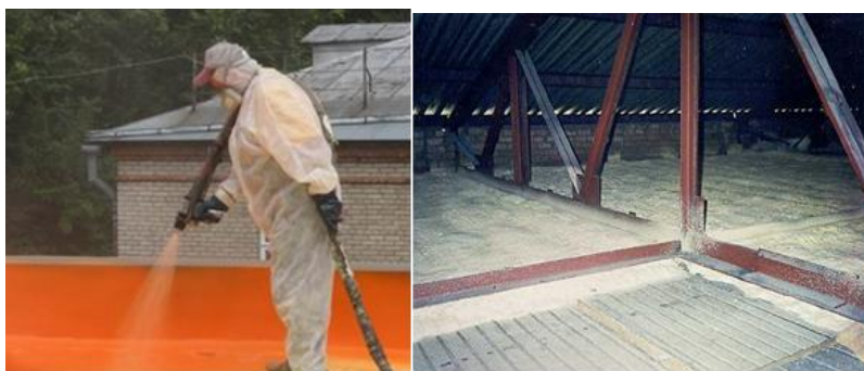
Рисунок 2.12 — Використання методу утеплення напленням пінополіуретаном:
